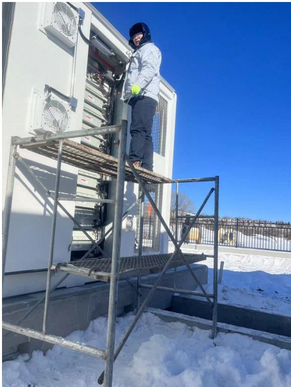
现场在脚手架上进行调试工作
