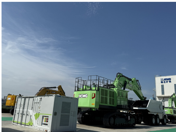
徐工工程机械现场
